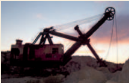
Excavadora Rustun. Cantera Brunita.
