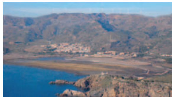
Zona de actuación del proyecto piloto, con las obras en marcha.
